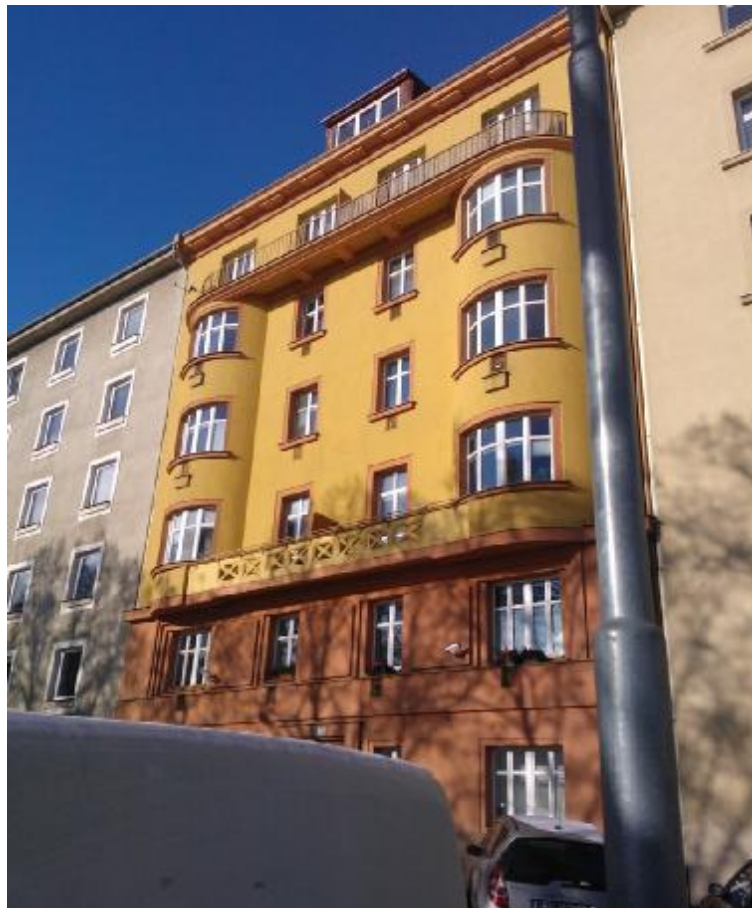
Celkový pohled na objekt – čelní fasáda - viditelné záření
