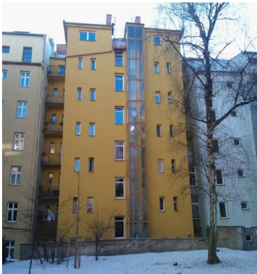
Celkový pohled na objekt – dvorní strana - viditelné záření
